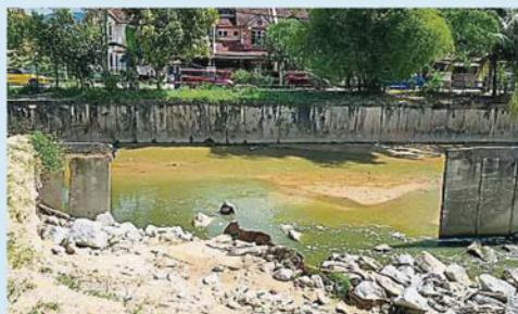
不堪山水溪道的冲击，万挠河河堤已被冲出一个大崩口。
